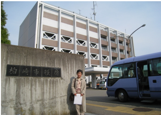
中越沖地震後の視察（耐震補強後の柏崎市役所）
