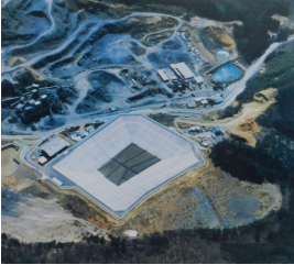
小俣処分場全景(建設当時)
